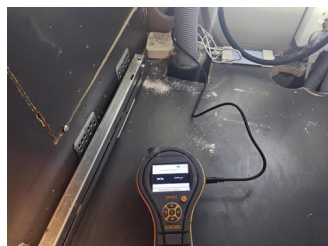
Utført kontroll i tilliggende konstruksjon - Fuktmåling
