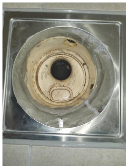
Tettesjiktets tilslutning til sluk - Sluk
