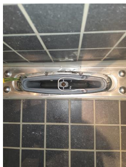
Tettesjiktets tilslutning til sluk - Sluk
