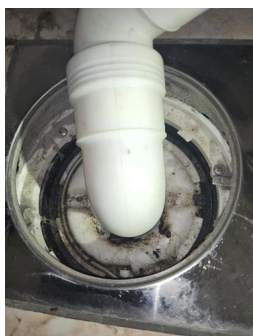
Tettesjiktets tilslutning til sluk - Sluk 1
