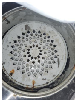
Tettesjiktets tilslutning til sluk - Sluk 2
