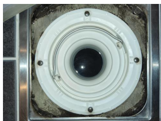
Vanntett sjikt / membran i gulv og vegger - Sluk på baderom
