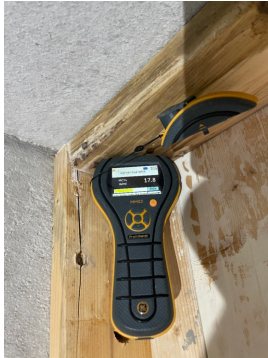
Bilde viser fuktmåling i yttervegg bod på balkong.
