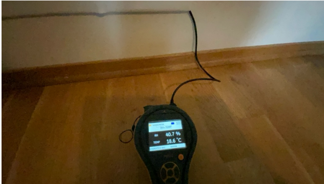
Bilde viser måling av luftfuktighet (RF)
