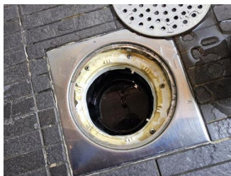
Tettesjiktets tilslutning til sluk - Sluk
