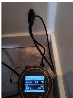
Utført kontroll i tiliggende konstruksjon - Fuktmåling
