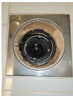
Tettesjiktets tilslutning til sluk - Sluk bad
