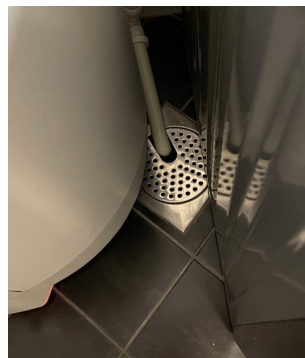
Sluk ved vaskemaskin (ikke tilgjengelig for innvendig inspeksjon).
