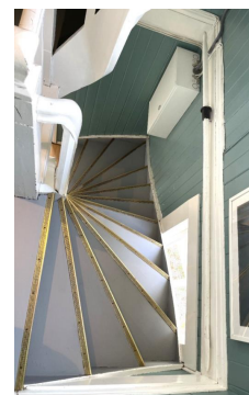
Trapp fra 1. til 2. etasje sett ovenfra
