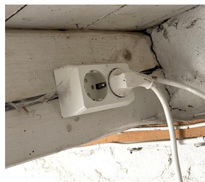
Ikke forskriftsmessig strømtilkobling
