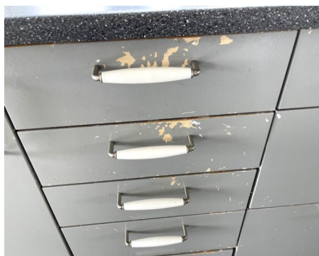
Eksempel på overflateslitasje
