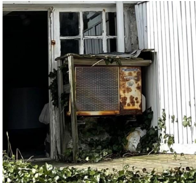
Rusten utedel av den eldste varmpumpen
