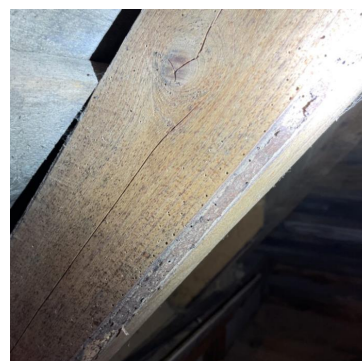
Borehull etter mit i taksperr
