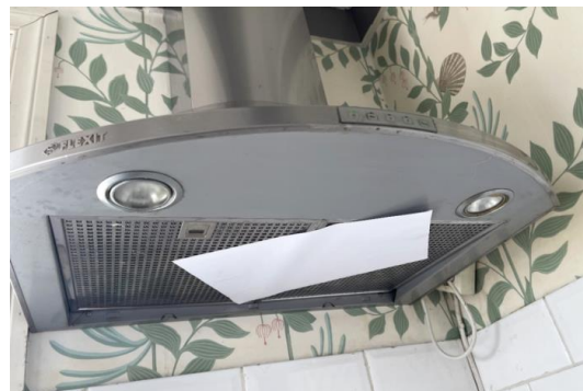
Ventilator bestod papirtesten
