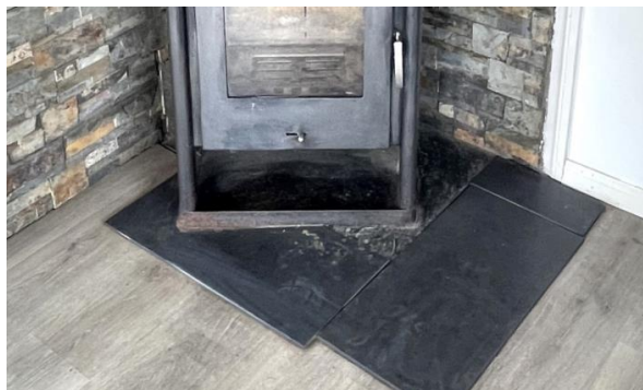
Delvis manglende ildfast plate foran ildsted
