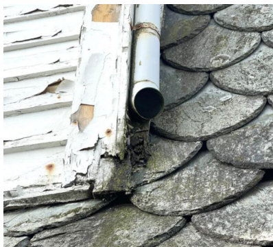
Nedløp fra takoppløft mot øst som fukter omkringliggende treverk
