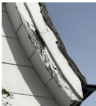
Nedløp fra takoppløft mot øst som fukter omkringliggende treverk
