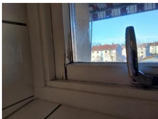
Overflater vegger - Vindu i dusjsonen
