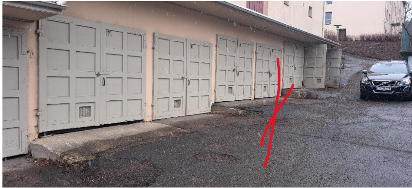
Bilde 1: Front av garasje anlegg, bestående av port i tre med stålramme rundt
