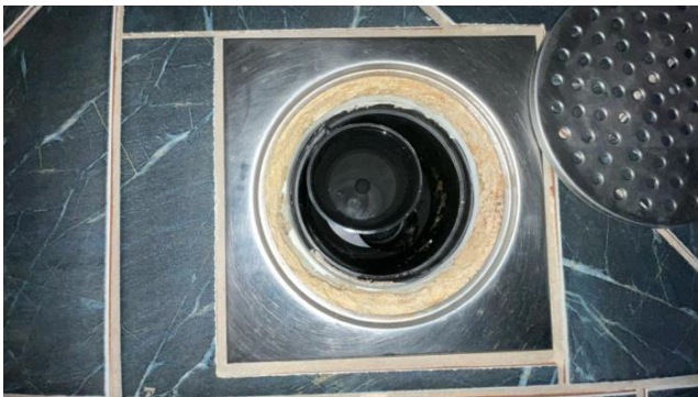
Bildet viser sluk.
