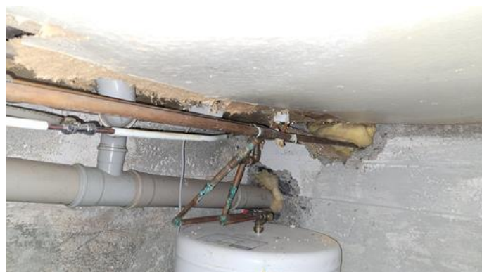
Tekniske anlegg, VVS anlegg (Sjekkpunkter utover det som er inkludert i andre rom) - [Rørøpplagg kjeller.]
