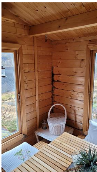
Utvendig - [Fuktskade frittstående uthus.]
