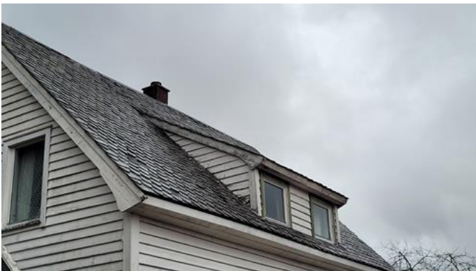
Utvendig - [Oversiktsbilde tak.]
