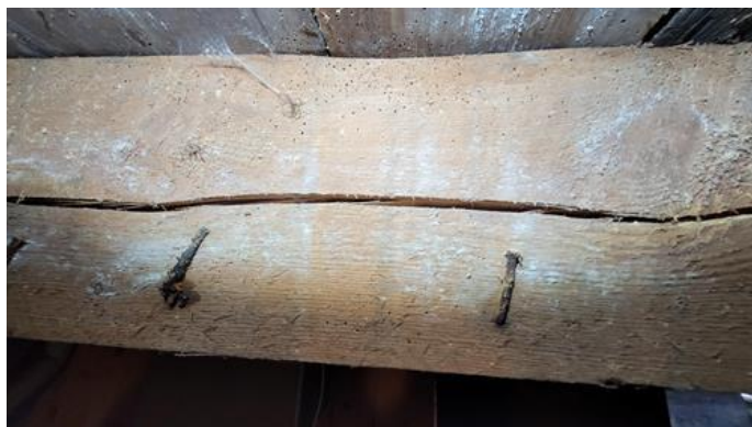
Rom under terreng (kjeller, underetasje, sokkeletasje) - [Spor etter treskadeinsekter.]
