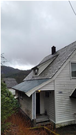
Utvendig - [Oversiktsbilde tak.]
