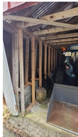
Utvendig - [Det er satt opp provisorisk vegg ved yttervegg for å forhindre utglidning.]
