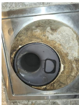
Tettesjiktets tilslutning til sluk - Sluk bad
