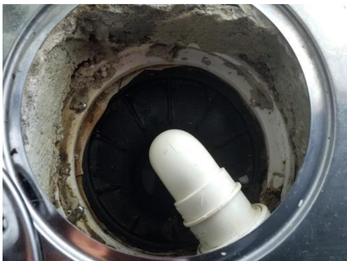
Membran, tettesjikt og overgang til sluk. - [Sluk i baderom under badekar. ]
