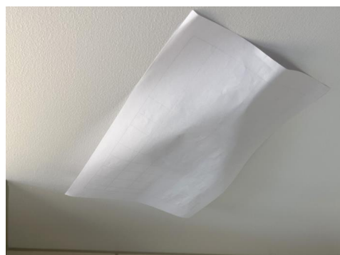
Avtrekksventil bestod papirtesten
