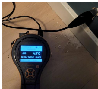
Utført kontroll i tilliggende konstruksjon - Relativ luftfuktighet
