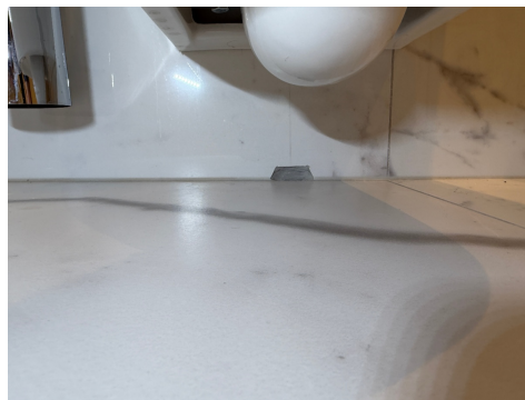
Dreneringshullet er fuget igjen.
