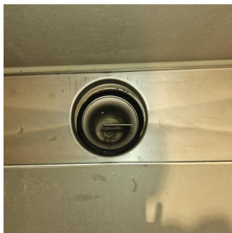
Tettesjiktets tilslutning til sluk - Sluk bad
