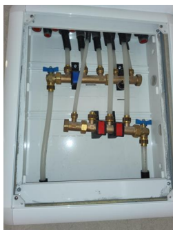
Vannrør - Fordelerskap
