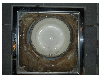
Tettesjiktets tilslutning til sluk - Sluk
