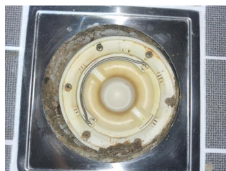
Tettesjiktets tilslutning til sluk - Sluk
