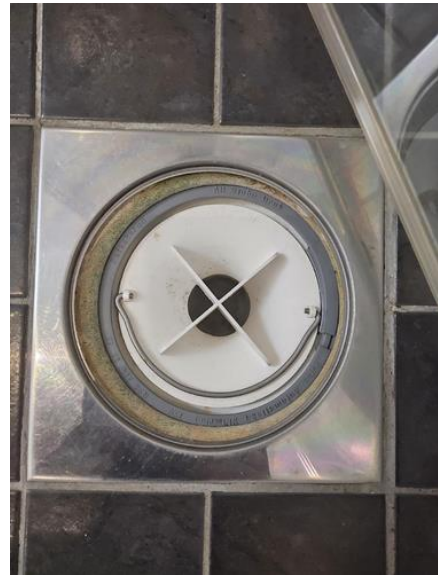
Membran, tettesjikt og overgang til sluk. - [Sluk]
