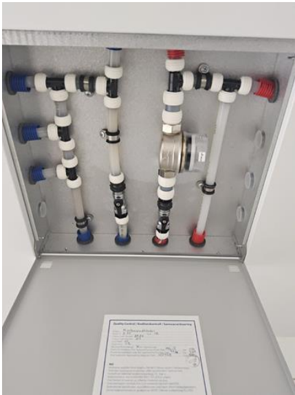
Vannrør - [Fordelerskap for rør-i-rør]
