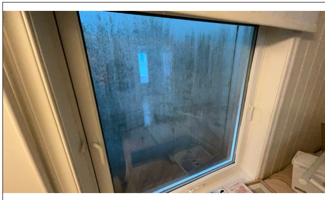
Sjakt med lite lys forhold pga utvendig sjakt/nabo bygg. Gjelder for et par vindu i 1. et.
