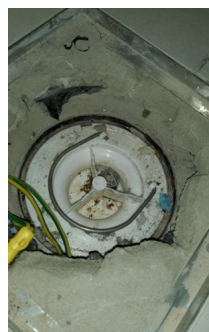
Tettesjiktets tilslutning til sluk - Sluk bad
