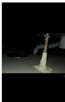
Tettesjiktets tilslutning til sluk - Sluk bad
