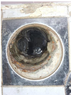
Tettesjiktets tilslutning til sluk - Hovedsluk bad
