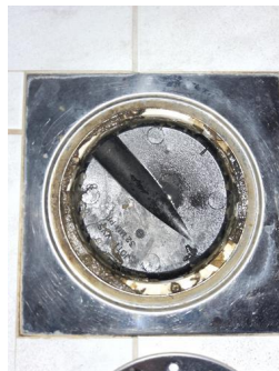
Tettesjiktets tilslutning til sluk - Hjelpesluk bad
