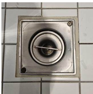
Tettesjiktets tilslutning til sluk - Sluk bad
