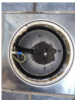
Tettesjiktets tilslutning til sluk - Hjelpesluk
