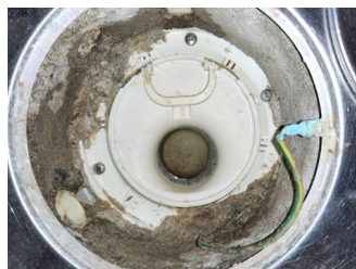
Tettesjiktets tilslutning til sluk - Hovedsluk
