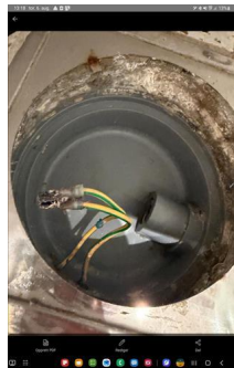
Tettesjiktets tilslutning til sluk - Hjelpesluk
