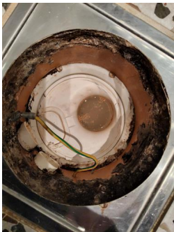
Tettesjiktets tilslutning til sluk - Hovedssluk
