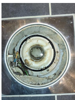
Tettesjiktets tilslutning til sluk - Sluk bad
