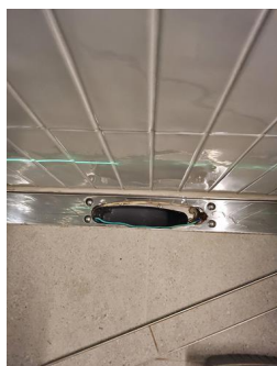
Tettesjiktets tilslutning til sluk - Sluk
