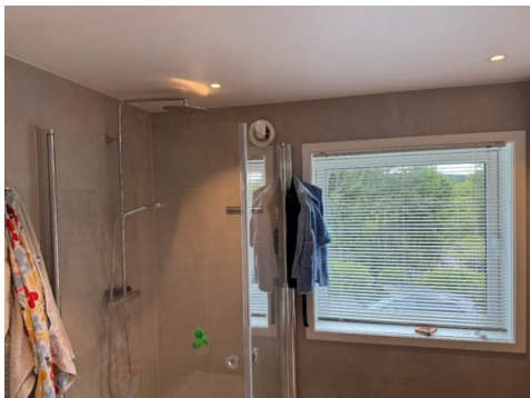
Bildet viser vindu i våtsone.
