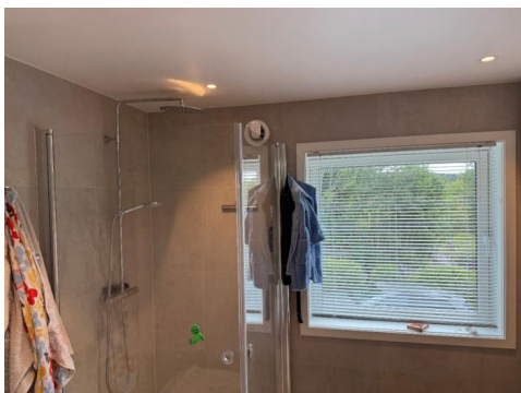
Bildet viser vindu i våtsone.
