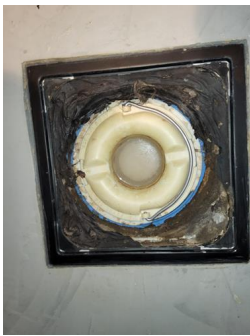
Tettesjiktets tilslutning til sluk - Sluk bad
