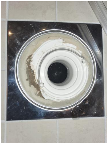
Membran, tettesjikt og overgang til sluk. - [Sluk bad tiliggende soverom ]
