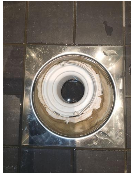
Membran, tettesjikt og overgang til sluk. - [Sluk bad med tilkomst fra hall]
