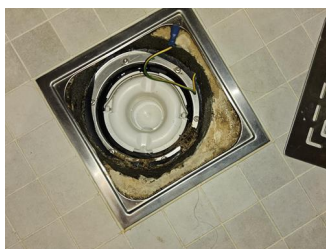
Tettesjiktets tilslutning til sluk - Sluk, bad.
