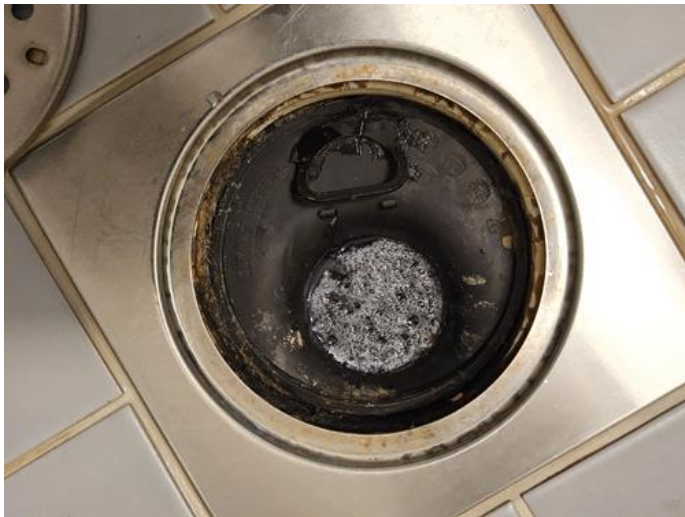
Membran, tettesjikt og overgang til sluk. - [Sluk.]
