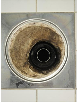
Tettesjiktets tilslutning til sluk - Sluk bad
