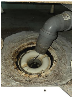
Tettesjiktets tilslutning til sluk - Sluk bad
