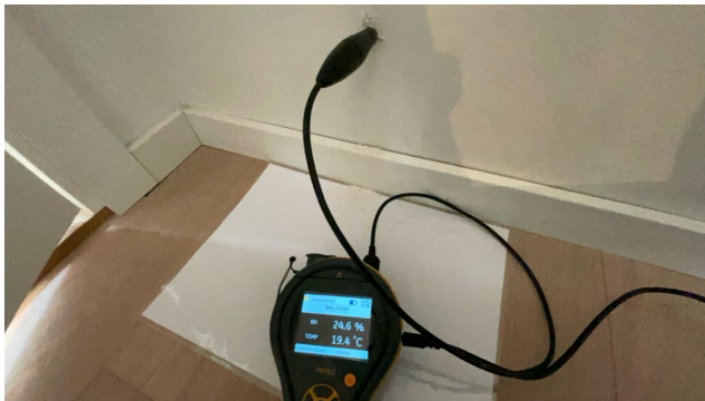
Bilde viser måling av luftfuktighet (RF)
